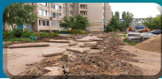
Ремонт дворовых территорий
